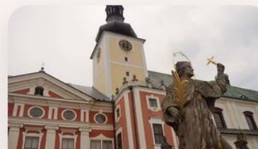
Revitalizace Broumovského kláštera
