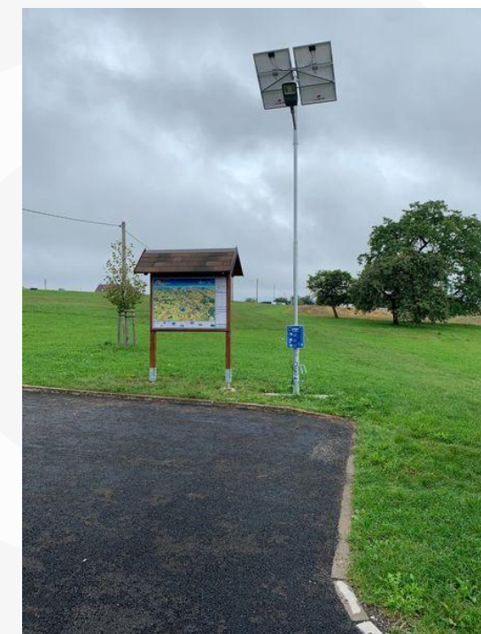
Solární elektro stanice obec Zábrodí
