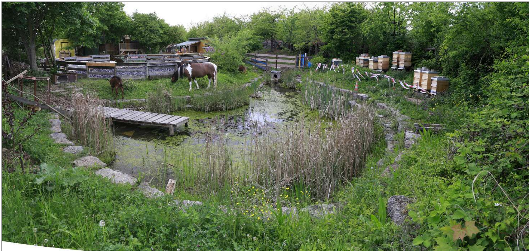
Retenční nádrž venkovského charakteru na odvodnění v ul. Blaumeisenweg (foto Ing. J. Vítek, 05/2014)
