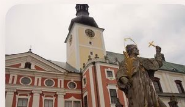
Revitalizace Broumovského kláštera
