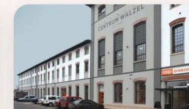
Revitalizace továrny v Meziměstí – Centrum Walzel
