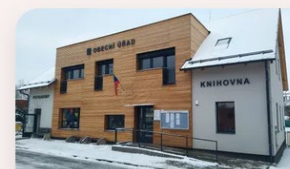
Multifukční objekt v obci Blešno
