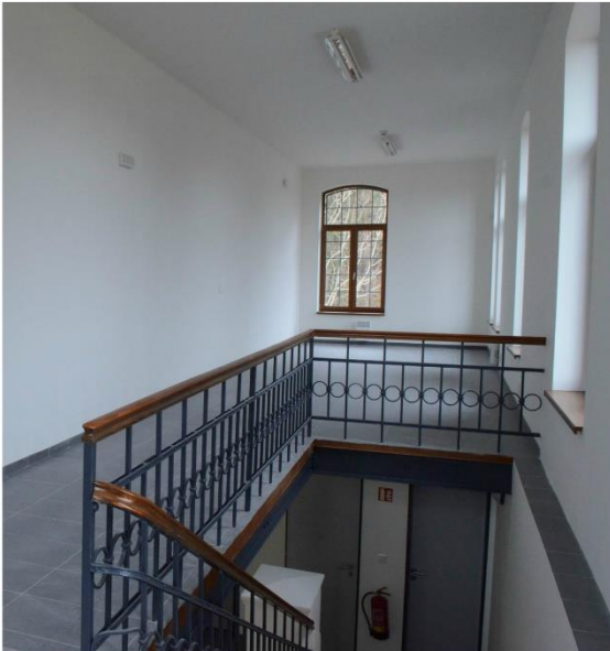
Centrum Walzel Meziměstí, zábradlí
